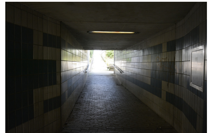
Unterführung an der Wilhelmstraße
