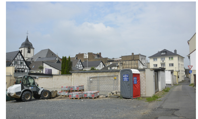
Blick auf die Hinterhöfe am Kleinen Graben
