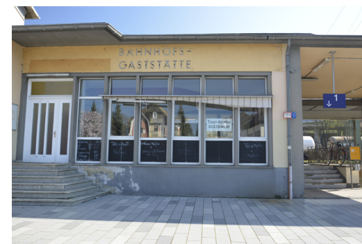
Teil des leerstehendes Bahnhofgebäudes
