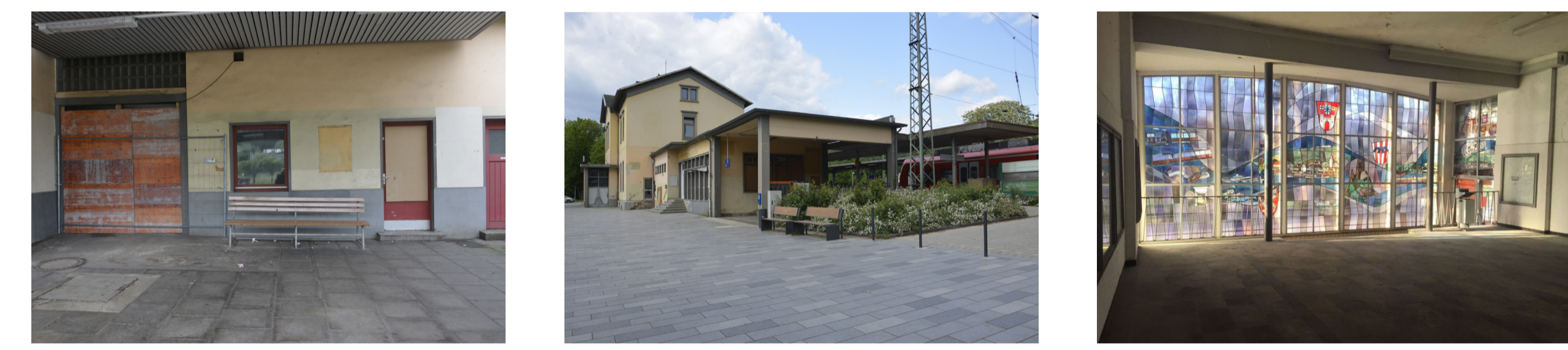
Ansichtsbaustrich Gebäuderückseite am Bahnhofsplatz
